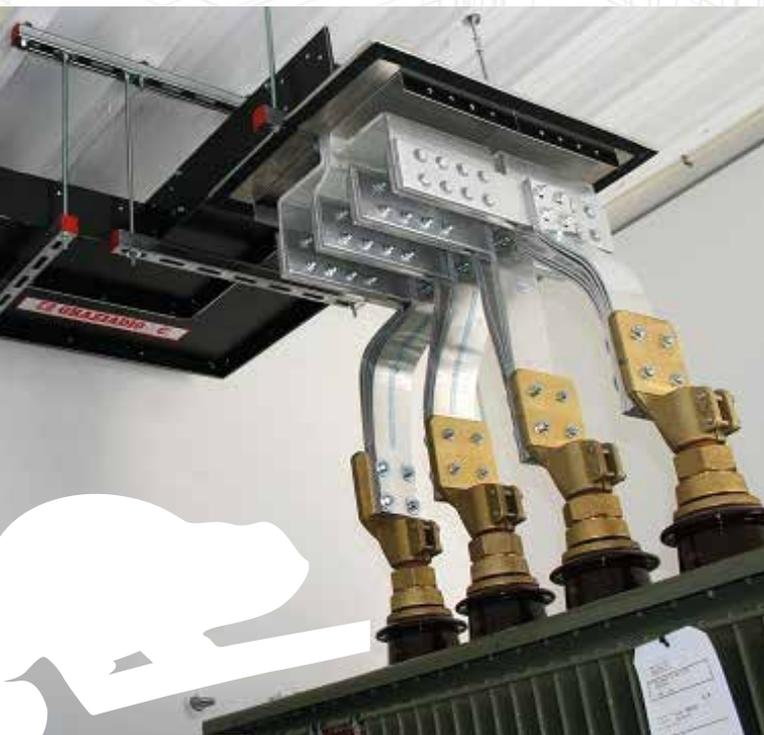
Per la realizzazione di un collegamento elettrico in bassa e media tensione tra condotti sbarre e trasformatori, quadri, alternatori o motori, la soluzione ottimale è rappresentata dalle connessioni flessibili. L'utilizzo dei flessibili attenuisce il trasferimento delle vibrazioni tra le due parti garantendo stabilità e durata nel tempo dell'insieme. La forma appositamente studiata del flessibile permette aggiustamenti di posizione (fino a 30 mm) senza dover rimuovere parti già installate.
